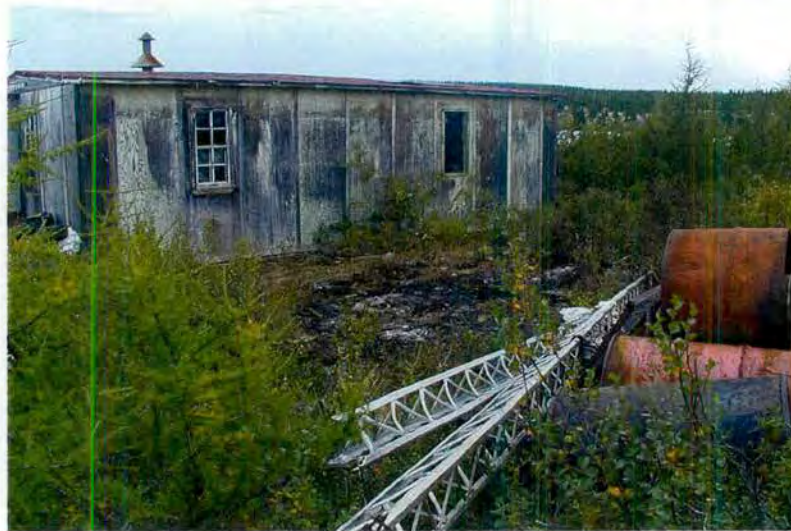
Photo 10. Aperçu du bâtiment du site 330A : avant nettoyage (photo en haut à gauche) et après nettoyage (les deux autres photos), en septembre 2000.
