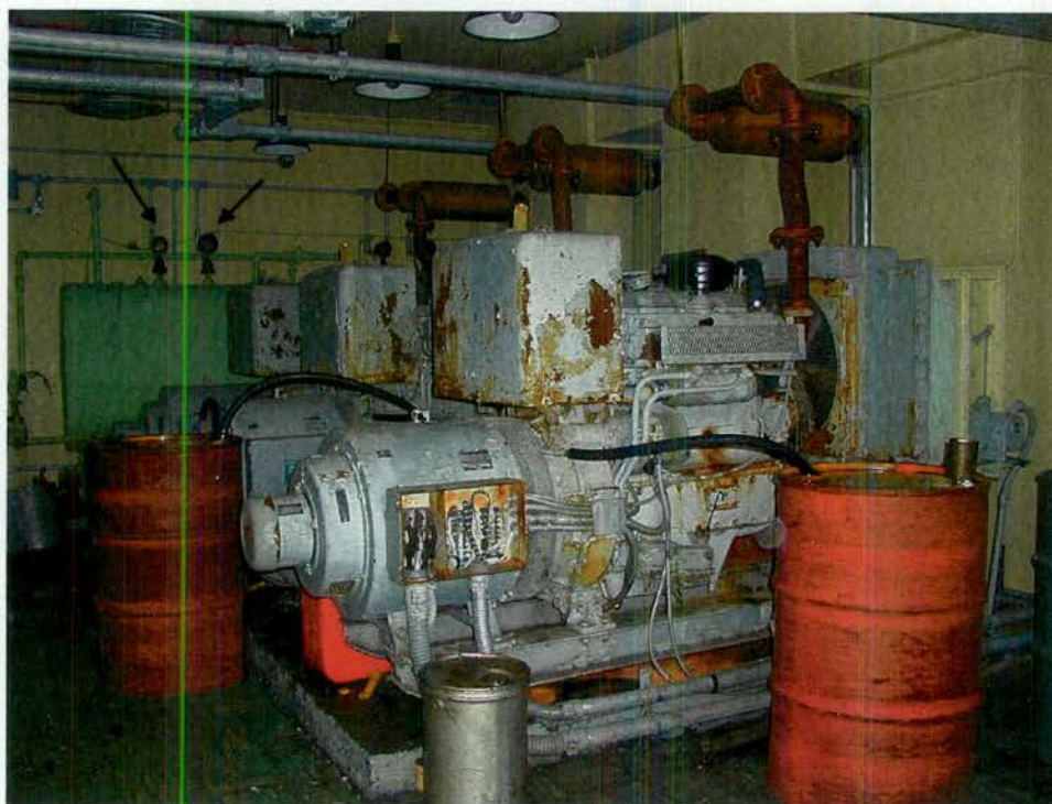
Photo 2. Vidange des réservoirs d'huile des génératrices au site 321 (8 septembre 2000). À remarquer : un des réservoirs de diesel au fond de la salle surmonté de boîtes métalliques rondes (voir les flèches) contenant des interrupteurs au mercure.
