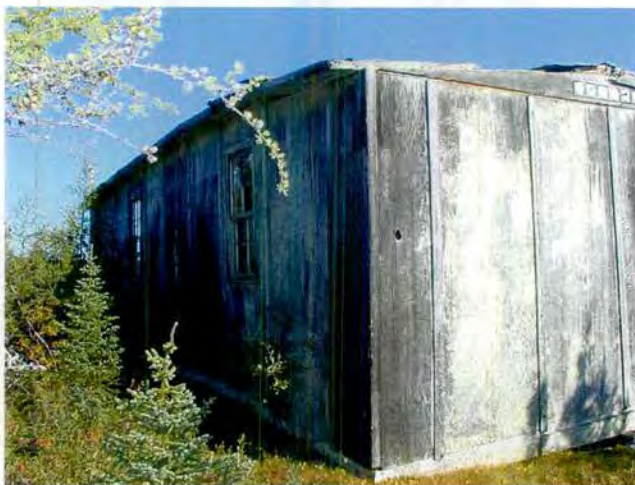
Photo 13. Vues aériennes du site 321A avant nettoyage (8 septembre 2000) et après nettoyage (11 septembre 2000). Vue arrière du bâtiment où la fondation s'est affaïcée.
